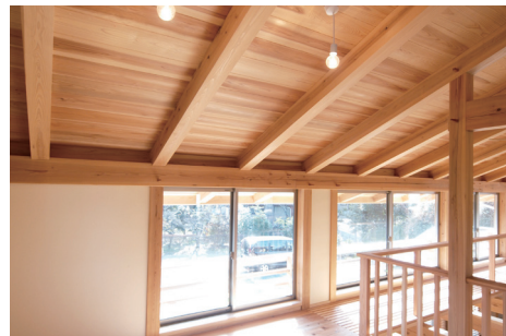
写真 3-1-20 化粧野地・面戸板現しにした例
