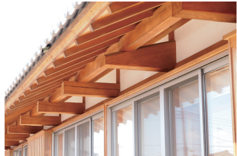
写真 3-1-19 出し梁及び出し桁
