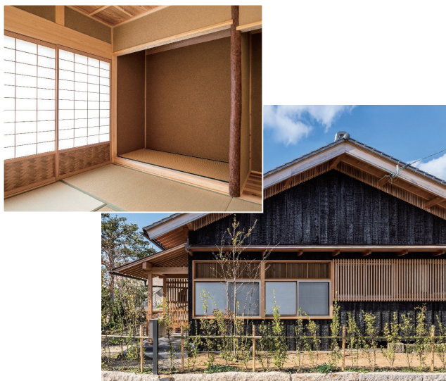
写真 2-3 片面真壁造の土塗壁
