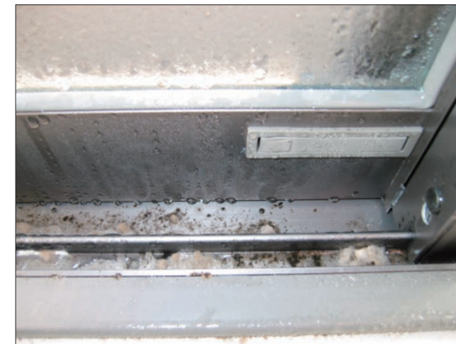
窓ガラス、サッシの結露
